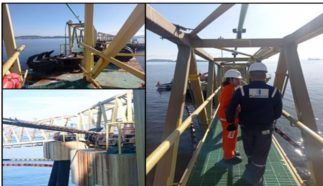
Figura 11 – Passarelas de acesso aos píeres de atracação do TABG (RJ) com estruturas passíveis de instalação de redes de contenção para o isolamento de aves Sterna hirundinacea da força de trabalho.
